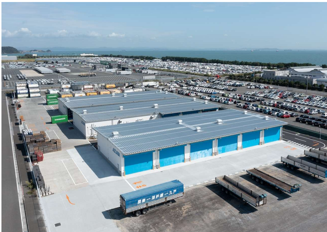
【危険物倉庫 3 棟目 外観②】
