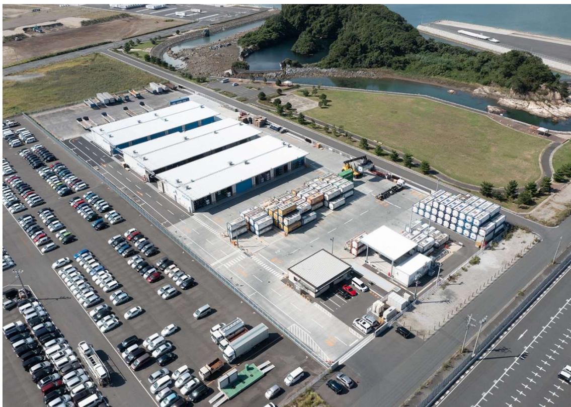
【危険物マルチワークステーション全体写真】
